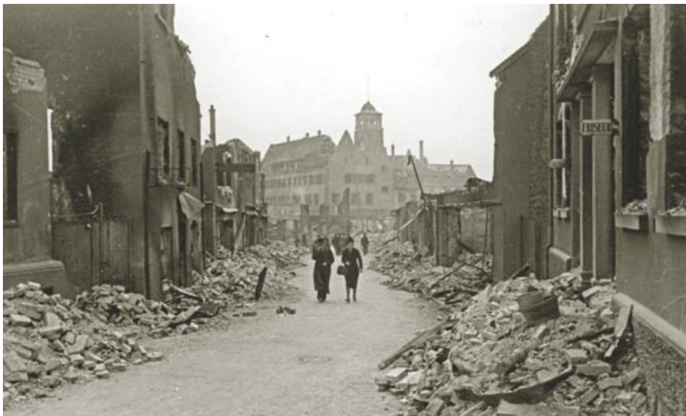
Die Wilhelmstraße am 30. April 1944.
